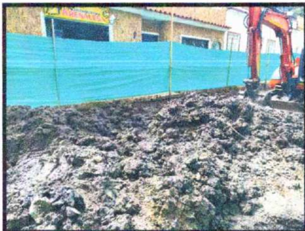
Extracción de material afectado y en malas condiciones
