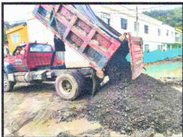
Extracción de material afectado y en malas condiciones
